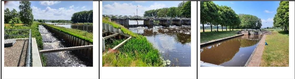
Abbildung 16: Fischtreppe (links), Wehr (Mitte) und Schifffahrtsschleuse (rechts) an der Vechte (Fotos Marnix van der Vat)
